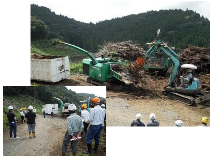
林業事業体、県・市町村の林務担当者等も参加した地拵作業の省力化に繋げる末木枝条のチップ化等の現地検討会（白川・菊池川）
