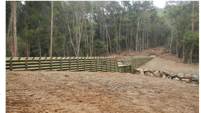
木材を利用した治山ダム（長崎北部）
