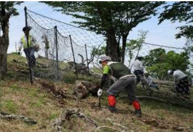
造林地や希少な植物を保護するため獣害防止ネットを設置する様子（球磨川）
