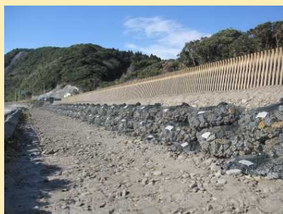
護岸工(串間市)
