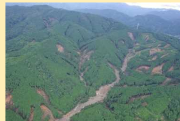
被害状況(朝倉市)
