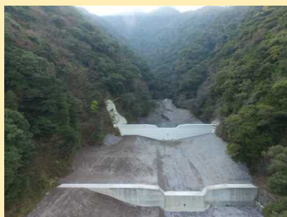
治山ダム(島原市)
