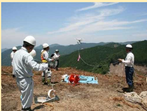
ドローンによる架線設置（熊本南部署）
