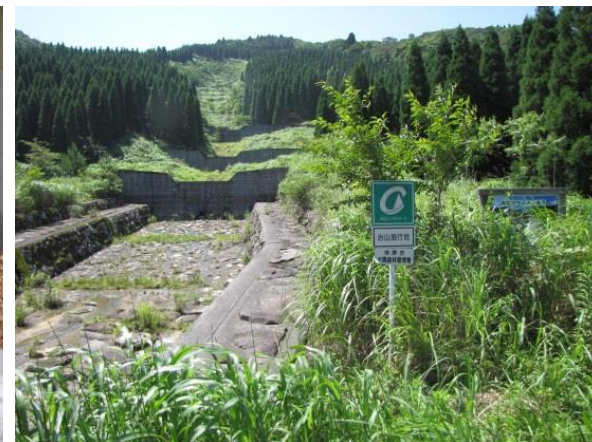
山地災害箇所の復旧跡地
