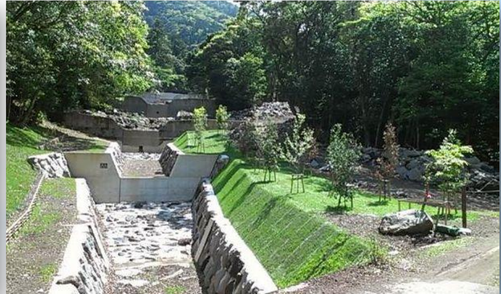
霧島山系流域に施工した治山施設
