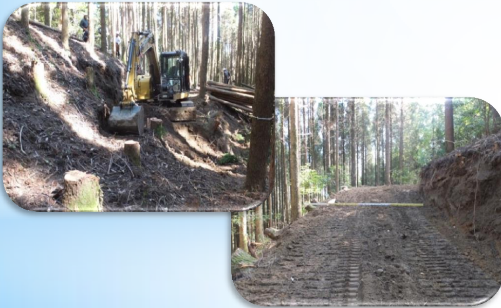
都城支署管内における路網の作設風景
