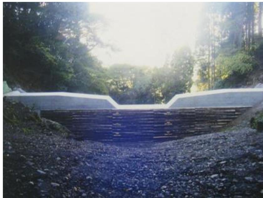
コンクリート谷止工の上流部に木材利用拡大を図るための間伐材を利用した丸太残存型枠を施工しています。
