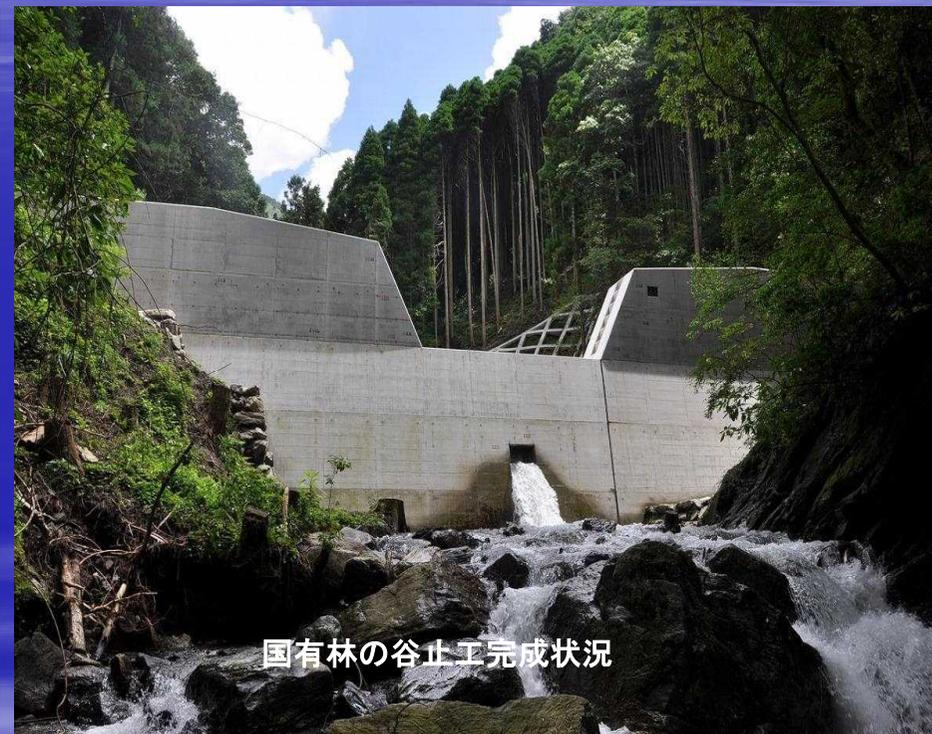
平成19年8月の台風4号の災害により国有林内を発生源とする崩壊土砂が下流域まで流出したため、発生源対策を国有林で、流送区間における不安定土砂対策、溪岸浸食防止対策を民有林において連携的に実施し、下流地域住民の安全を図っています。
