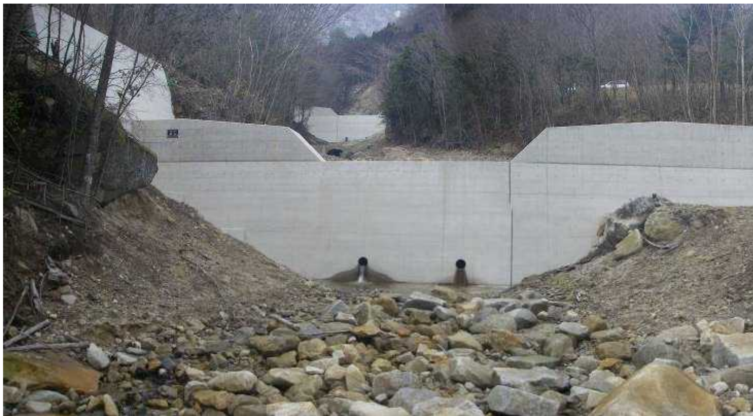
日之影町 上鹿川地区
