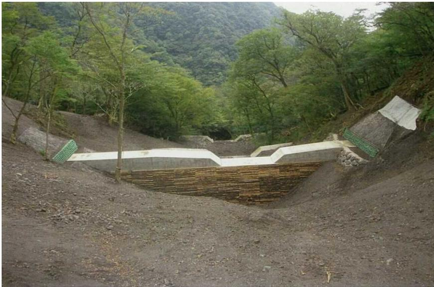
荒廃した溪流では、不安定な土砂の流下抑止と山脚の固定を図るため、計画的に溪間工を実施しています。また、施工に当たっては間伐材を使用した型枠や現地発生の自然石を積極的に使用しています。
