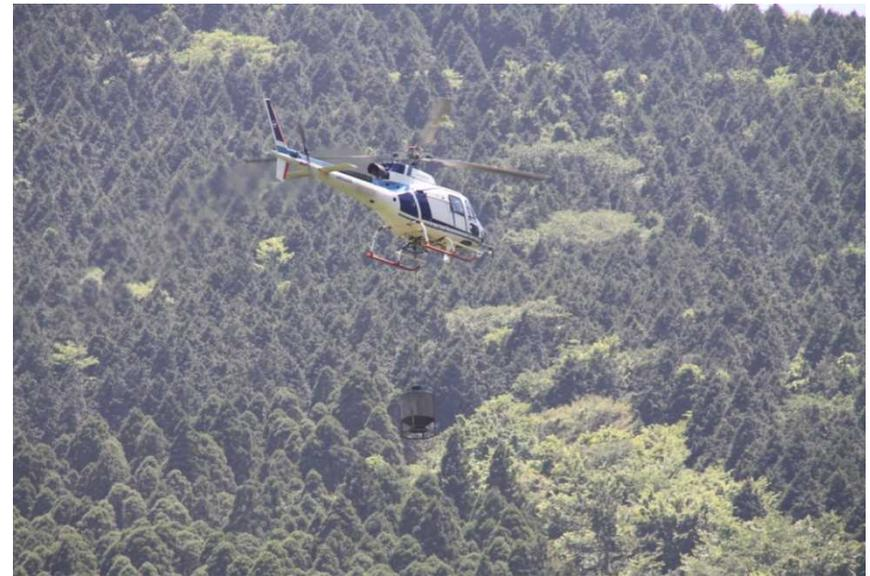
災害により崩壊した山腹上部の斜面については、早期復旧と拡大防止を図るため、ヘリコプターによる航空実播工等を実施しています。
