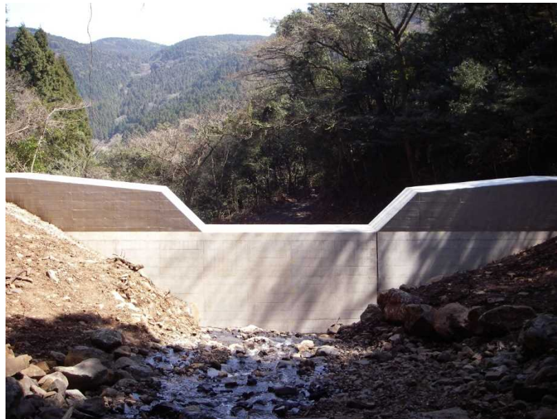
伊万里地区のコンクリート谷止工
