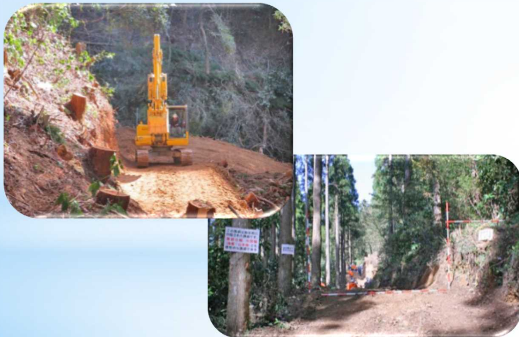
宮崎森林管理署管内における路網の作設風景
