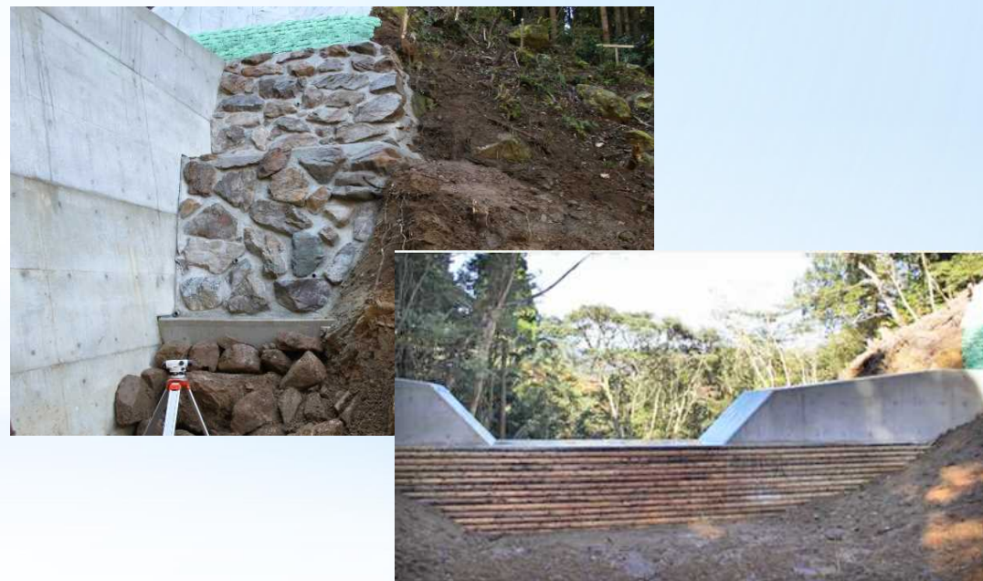
宮崎森林管理署管内に施工した治山施設
