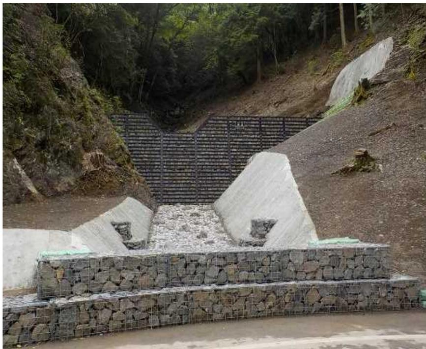
鋼製自在枠谷止工
