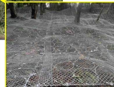
鹿児島県大島郡小勝地区において、集落近隣の急斜面地において、落石の危険があるため山腹工を実施しました。工種としてリングロープネット工を採用したため立木伐採を最小限にとどめ、また、地表植生が甦生し山林へ戻ることが期待出来るとともに、落石防止に効果があります。
