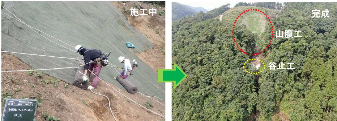
台風により被災した、山腹崩壊地の早期復旧を図るため、山腹工等により、法面の安定と早期緑化に取り組みます。
