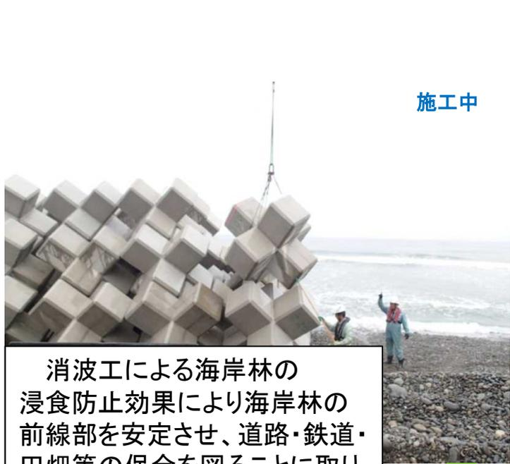
消波工による海岸林の浸食防止効果により海岸林の前線部を安定させ、道路・鉄道・田畑等の保全を図ることに取り組みます。
