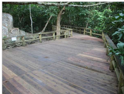
(写真 1-12) 観察木道デッキ(修繕後)
