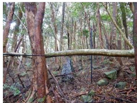
写真 6-1 No. 1 (H23) 倒木によるネット破損状況
