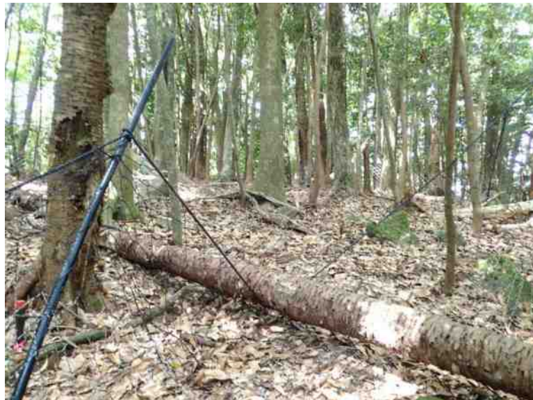
No.3 (旧No.1-2) 植生保護柵 倒木による破損
