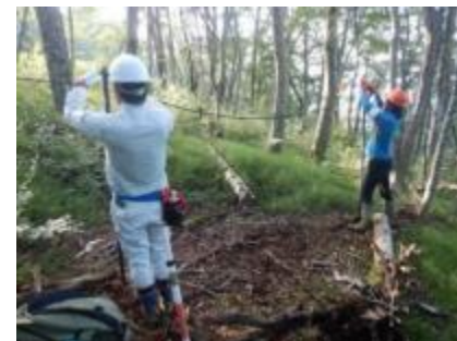
植生保護柵の保守点検状況-2
