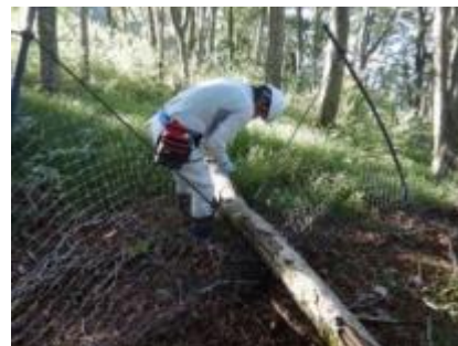
植生保護柵の保守点検状況-1
