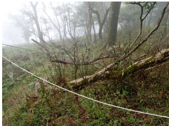
写真 20 倒木のため壊れたシカ防護柵。
