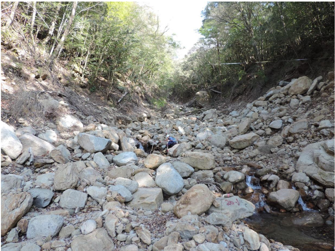
写真3 不安定土砂の堆積状況(測点 No.22)
