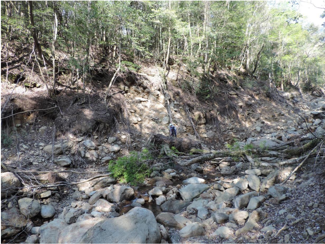
写真 4 右岸側の溪岸崩壊・侵食状況(測点 No.26)
