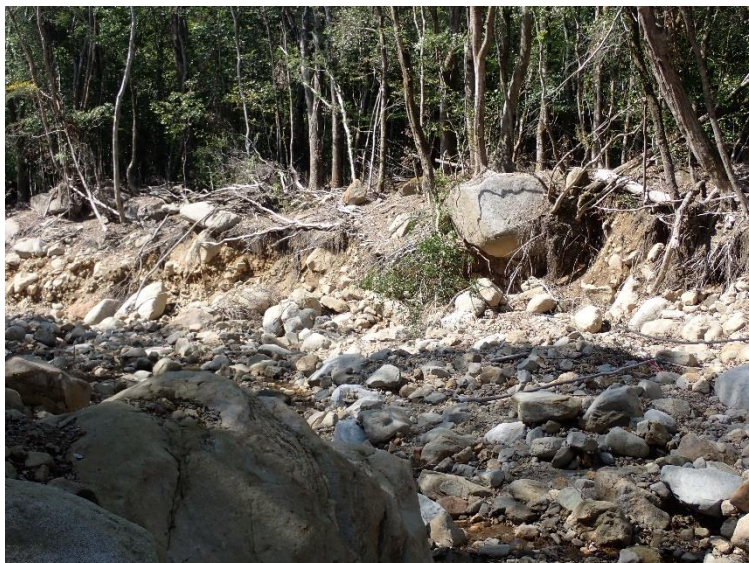
写真1 侵食状況(測点 No.12～15 付近 上流側から撮影)
