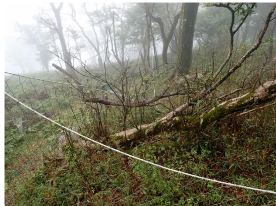
写真 20 倒木のため壊れたシカ防護柵。
