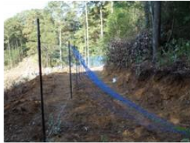
支柱+ロープネットを斜め張り
