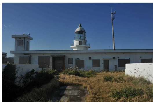
写真3 女島灯台施設
