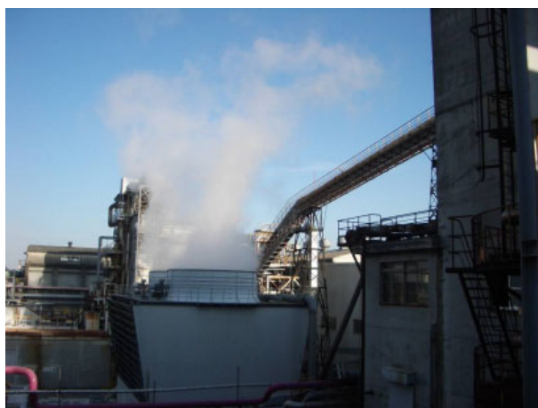
小型サイロと小型蒸解釜はベルトコンベアで直結
