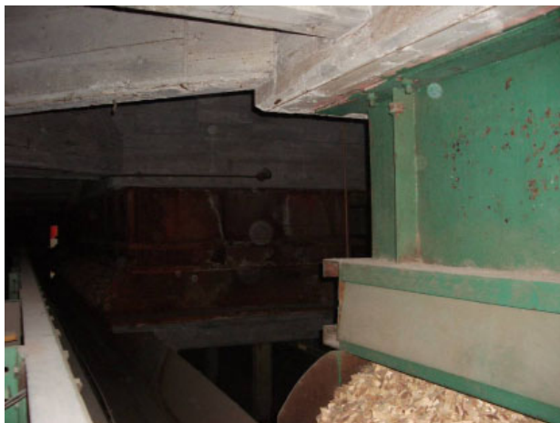
区画の切れ目(サイロは内部で5区画に分かれている)
