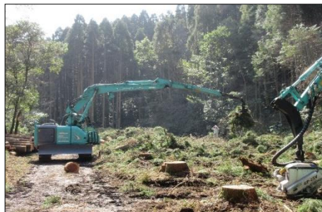
(伐採事業者による植栽作業(地拵え))
