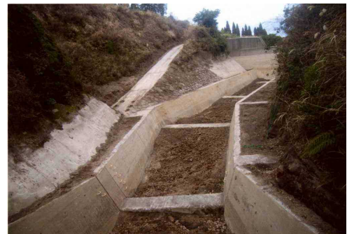
同 待受けダム排土後
