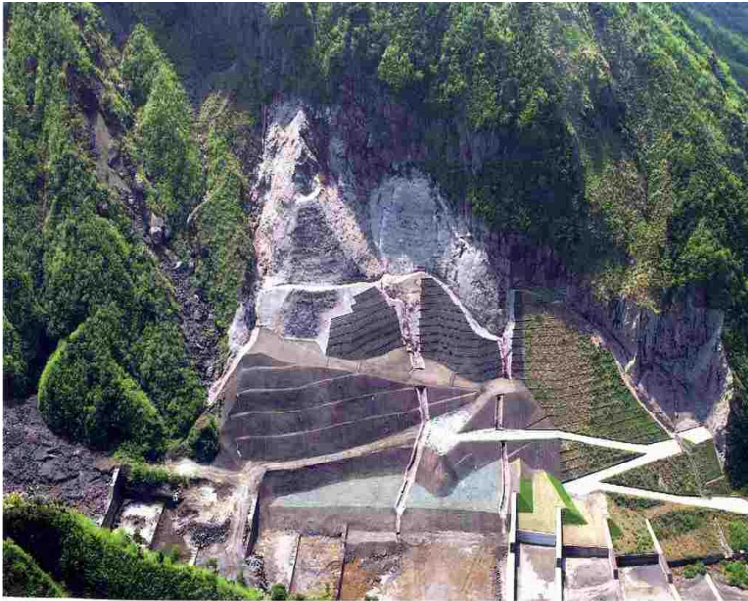
長谷川上流山腹工
