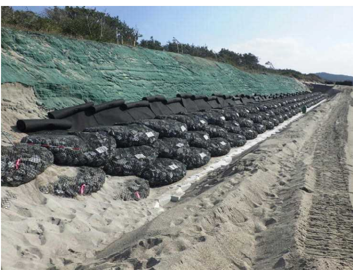
かご型護岸据付状況（3段目）
