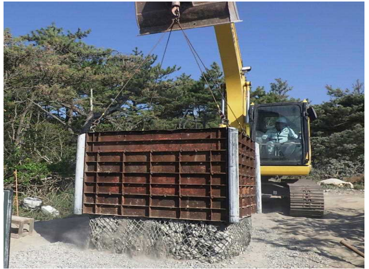
かご型護岸（制作状況）
