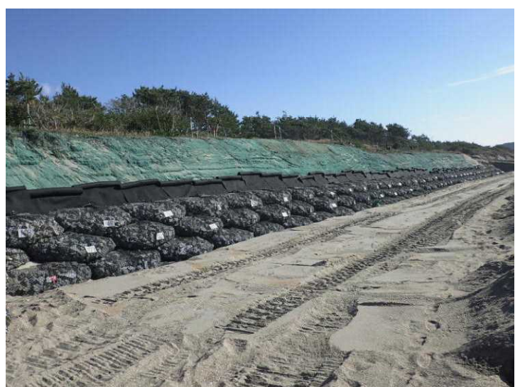
かご型護岸据付状況（5段目）
