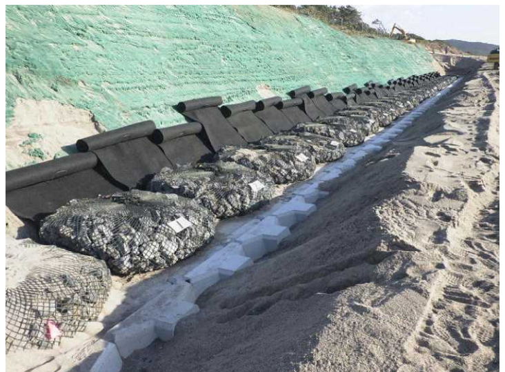
基礎部～かご型護岸据付状況（1段目）
