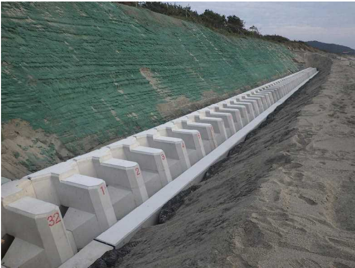
直立消波護岸工（基礎部）
