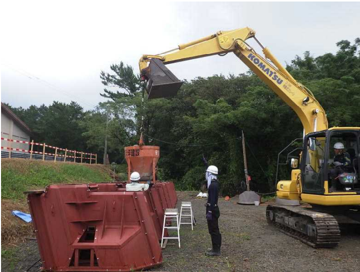
直立消波護岸工（制作状況）
