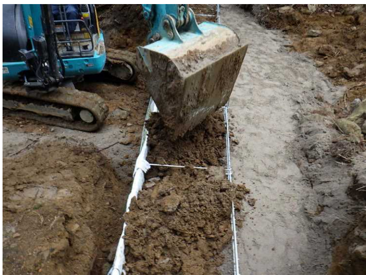
かご砕土留工制作状況
