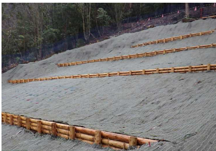
植生マット工（完成）
