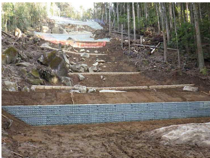
かご砕土留工（完成）
