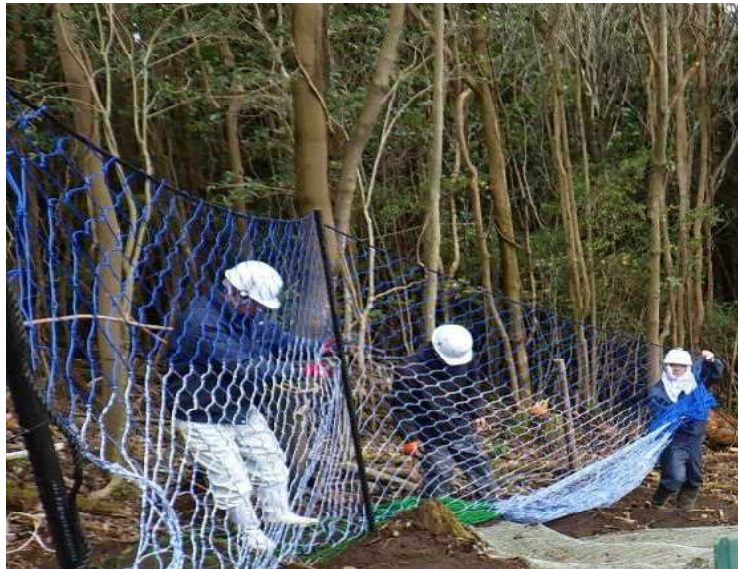
鹿侵入防止工
