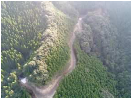
森林整備の基盤 林道新設箇所
