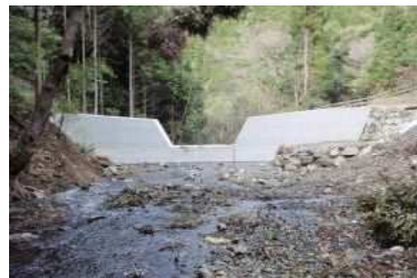
土砂流出の防備のための 治山工事箇所
