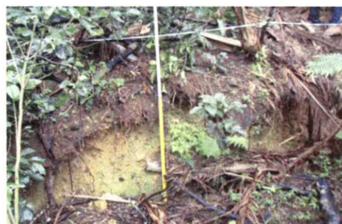
写真-3 地滑りと思われる箇所
