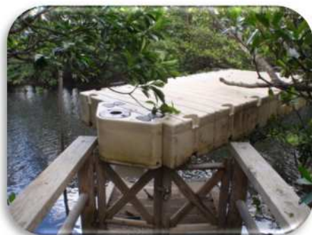
木道上に打ち上がった浮棧橋
