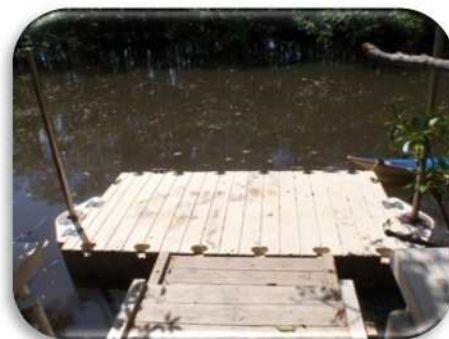
復旧後の浮棧橋
