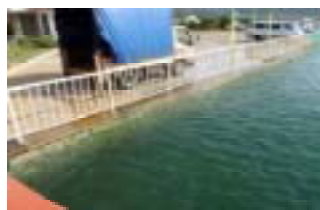
異常潮位の状況(大原港) 2009.7.24(8:48)
