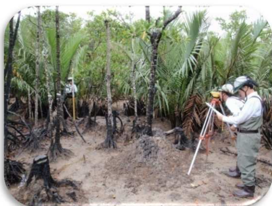
写真 4 地盤高測定風景
