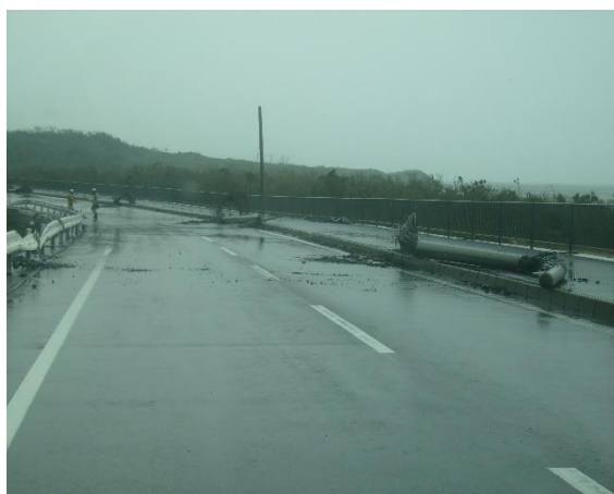
台風による被害（電柱の倒壊現場）
