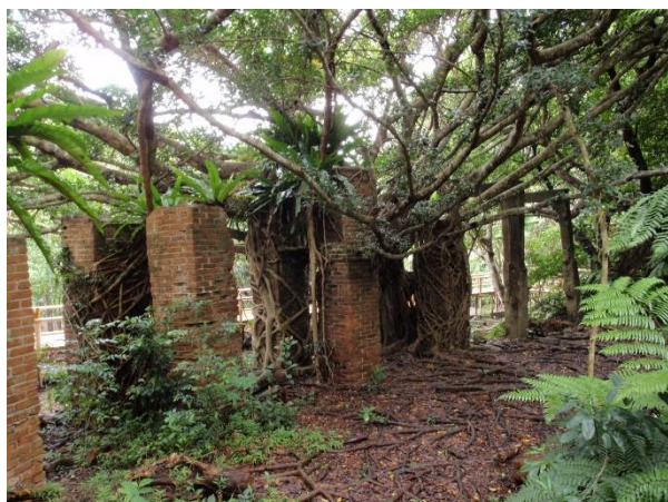
宇多良炭坑橋脚跡
