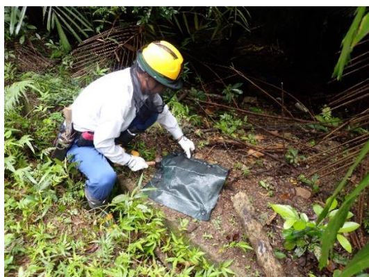
（写真11）防草シートを設置する職員
