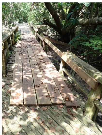
（写真 27）修繕された連絡道
