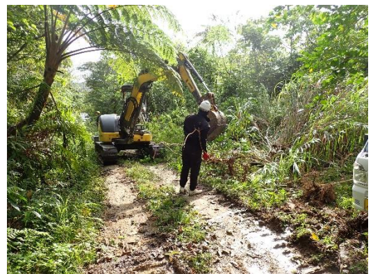
（写真13）重機による抜き取り作業
