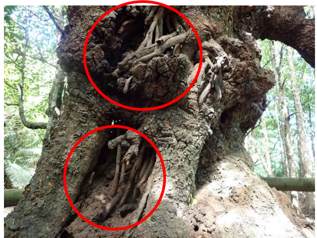
【写真6 腐朽部から伸びる不定根】
