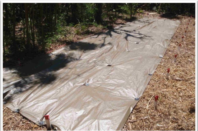
設置した防草シート
