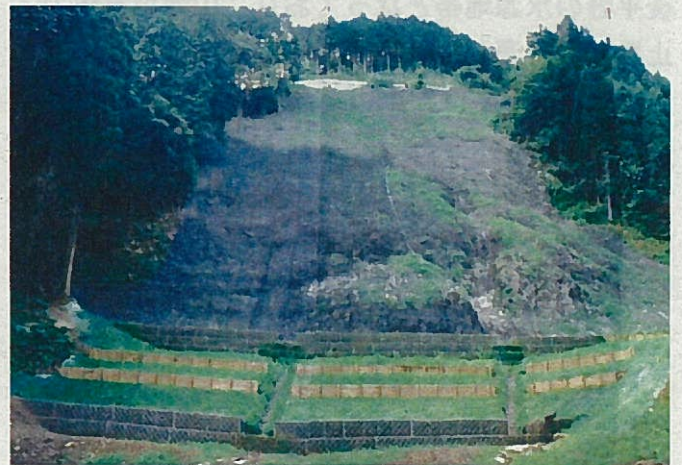
山腹崩壊地における緑化工事をして 森林を造成しています。
