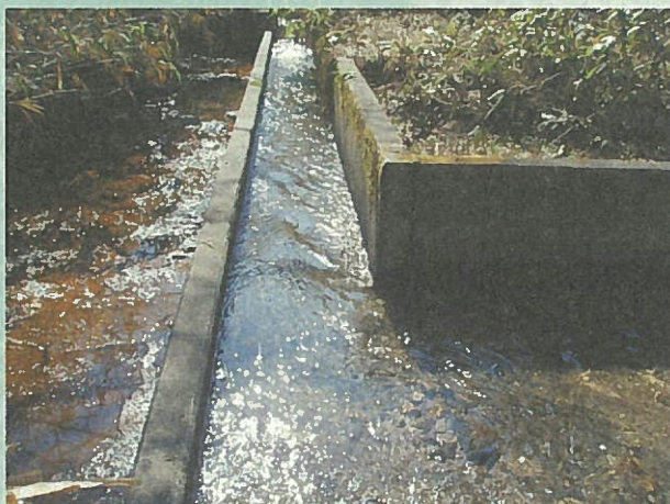
蛤水道（松隈九瀬谷国有林）
