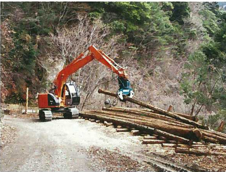
グラップルによる集材・造材作業
