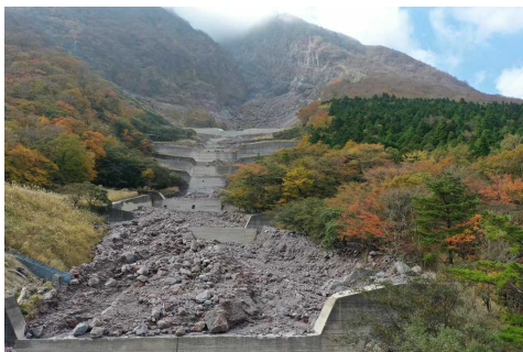
由布岳北側崩壊地治山工事箇所
