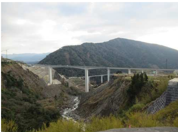
立野 57 号線から見た 北向山スギ等遺伝資源希少群保存林 (北向山国有林 116 林班・手前新阿蘇大橋)
