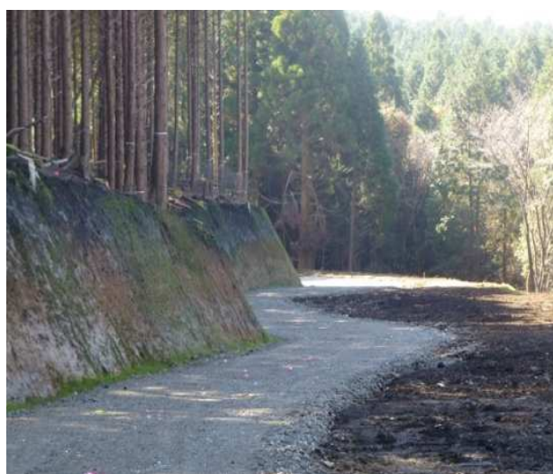
ガーリロード沿い 吉無田林道 新設箇所 （大野国有林野1130林班）
