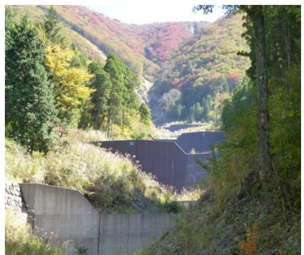
北里川上流の土砂流出防止谷止工群 （源太園国有林240林班）
