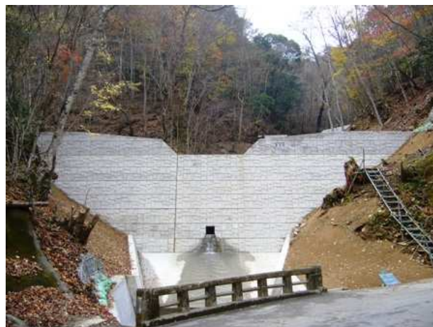
治山ダム施工後（傾山国有林）
