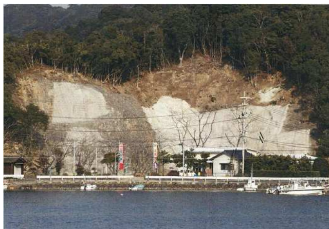
山腹工施工後（大江灘国有林）
