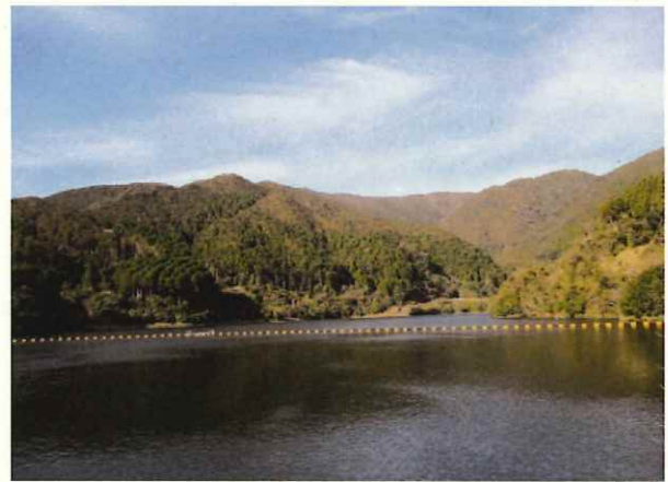
▲ 切原ダムから国有林を望む
