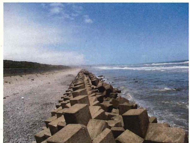
▲ 消波ブロックの設置状況
