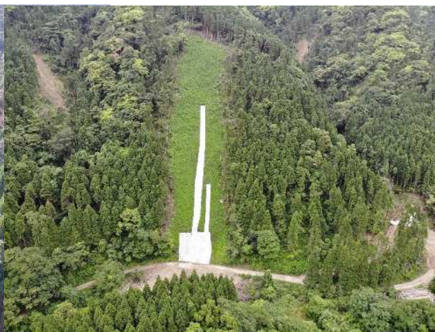
治山施設の復旧（復旧後）
