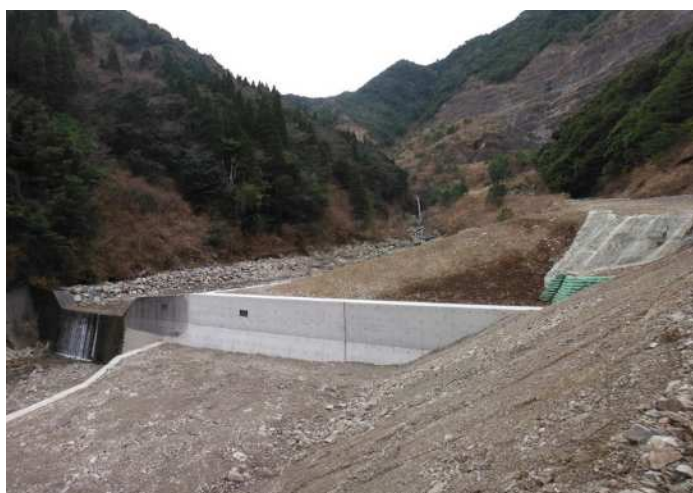
治山施設の復旧（復旧後）
