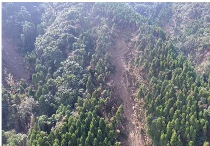
治山施設の復旧（施工前）
