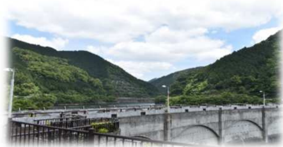
猪野ダム(多目的ダム)
