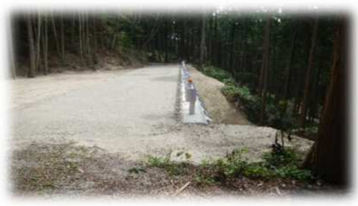
災害復旧工事(成竹林道)
