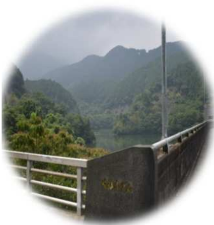
瑞梅寺ダム(多目的ダム)
