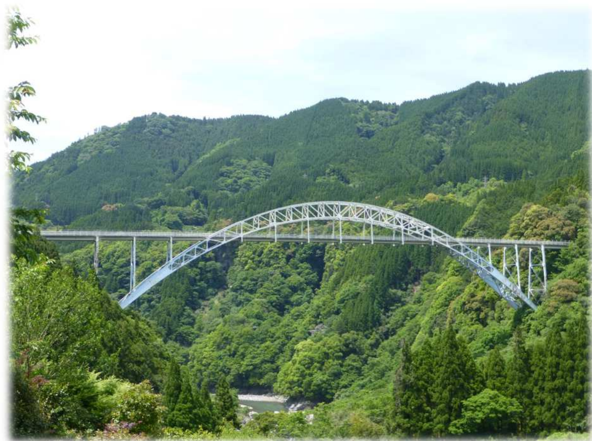
内大臣橋（山都町・美里町）橋長 199m 橋高 88m
