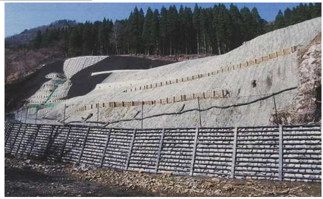
治山工事(地滑り防止事業) (七郎次国有林)
