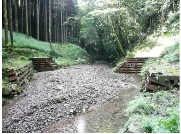
⑭治山施設：木製床固（段ノ頭国有林）
